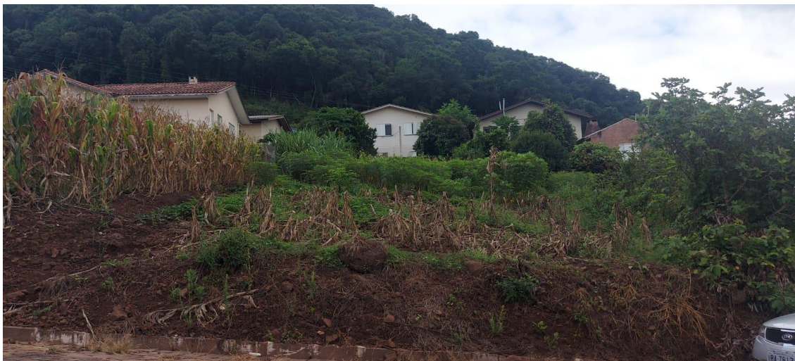
Figura 8: Frente do imóvel
