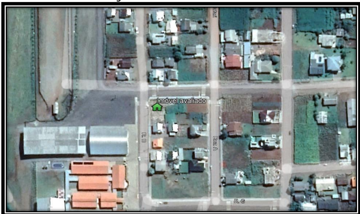
Figura 05 - Foto aérea do imóvel.
